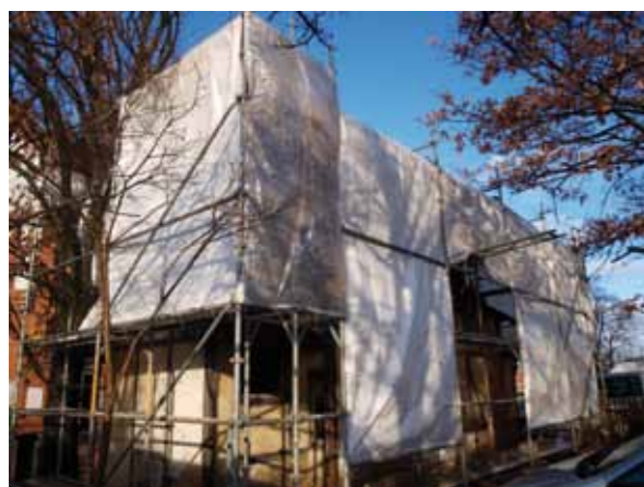
Sicherung des Kontorhäuschens
